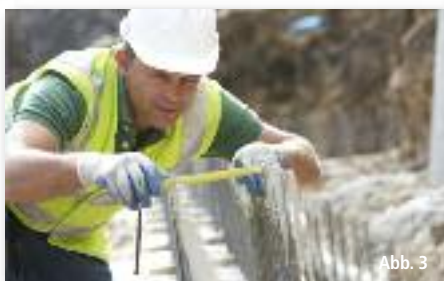
Einmessen und Verlegen der Stellrinne
