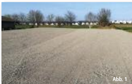
Vorbereitung des Untergrunds
