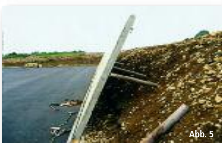
Die Montageabstützung gewähr- leistet eine gleichmäßige Schräge bis zur späteren Hinterfüllung
