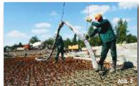
Betonieren der Bodenplatte inklusive der Aussparungen für die Wandplatten
